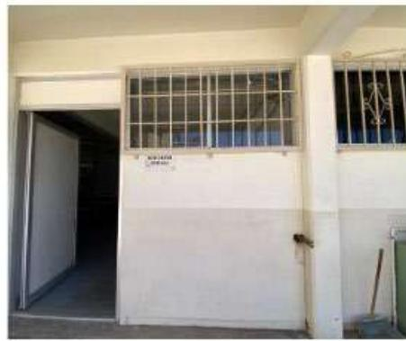
Ilustración 27. Reja de seguridad colocada
