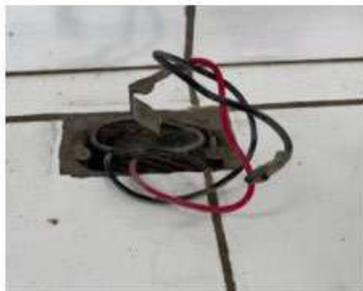
Ilustración 22. Falta de tomacorriente (Antes)
