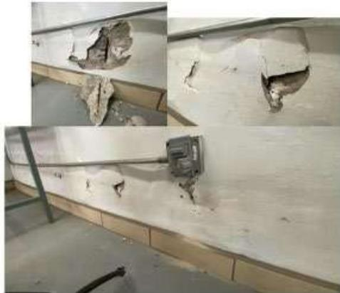
Ilustración 16. Paredes dañadas (Antes)
